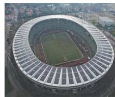
13.300 i pannelli fotovoltaici utilizzati, in grado di produrre circa 1 MW di energia pulita all'anno, evitando 550 tonnellate di CO<sub>2</sub> in atmosfera. L'energia prodotta e venduta, permetterà di ammortizzare in 20 anni l'investimento da circa 4 milioni.
